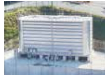
耐震性貯水槽
