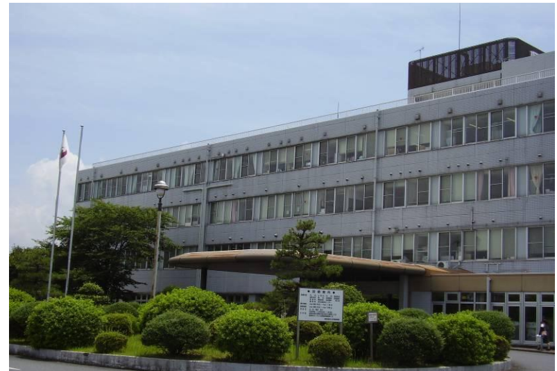
五條病院を改修
