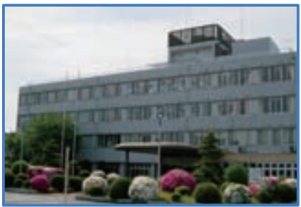
地域医療センター 県立五條病院を改修
